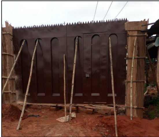
Kühlraum im Bau
